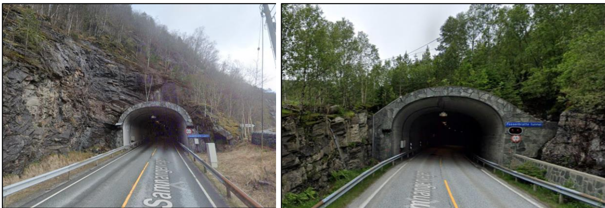
Figur 2. Vestlig og østlig tunnelpåhugg med betongportaler.
